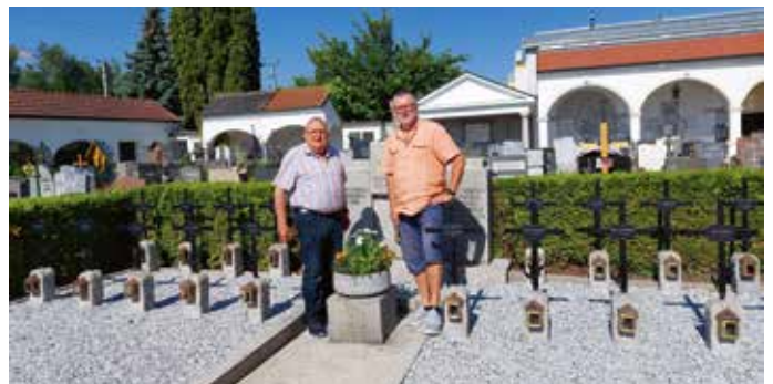
ÖKB-BO Josef Schwarzmanseder (li.) und ÖKB-Obm.Stv. Wolfgang Humer auf der generalsanierten Kriegsgräberanlage
