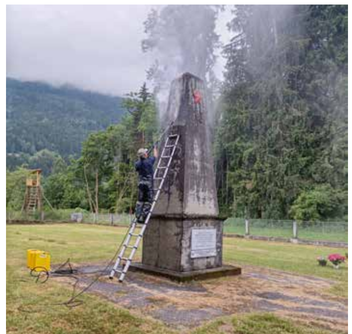
Reinigungsarbeiten am Obelisken des Russenfriedhofes Tangern
