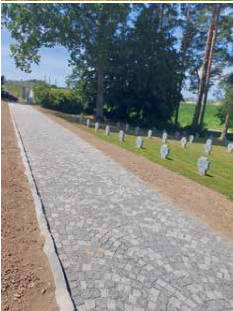
Pflasterungsarbeiten durch die Deutsche Bundeswehr am Soldatenfriedhof Freistadt-Jaunitzbachtal und der neu gepflasterte seitliche Zugangsweg
