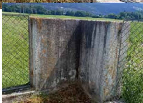
Friedhof Aich: Reinigung der Mauer, vorher (oben) – nachher (unten)
